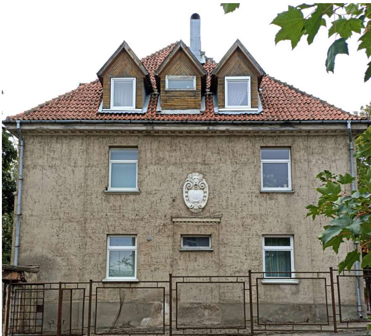
Buvęs skerdyklos administracinis pastatas 2022 m. Fotogr. Arvidas Jasmanis
