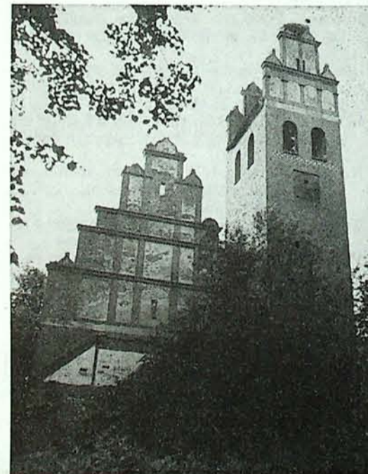
Fast überwuchert: Die Kirche in Groß Schirrau, Kreis Wehlau, scheint dank guter Baubsubstanz dem Verfall zu trotzen
