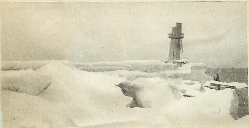
Ein Kunstwerk von großer Schönheit schuf Mutter Natur in weniger als 48 Stunden, als sie die alle Nordermole an der Einfahrt zum Pillauer Tief mit einem viele Tonnen schweren Eispanzer überzog. — Die sonst so geradlinige Mole mit ihren Schutzmauern um den roten Turm und mit ihren schweren Senkkästen davor, verschwand in einer meterdicken Hülle von blauweißem Eis, die nach jeder Sturzsee, die darüber hinwegging, dicker und dicker wurde; und barocke Wülste und Schrauben und Zacken von großer Regelmäßigkeit formte.
