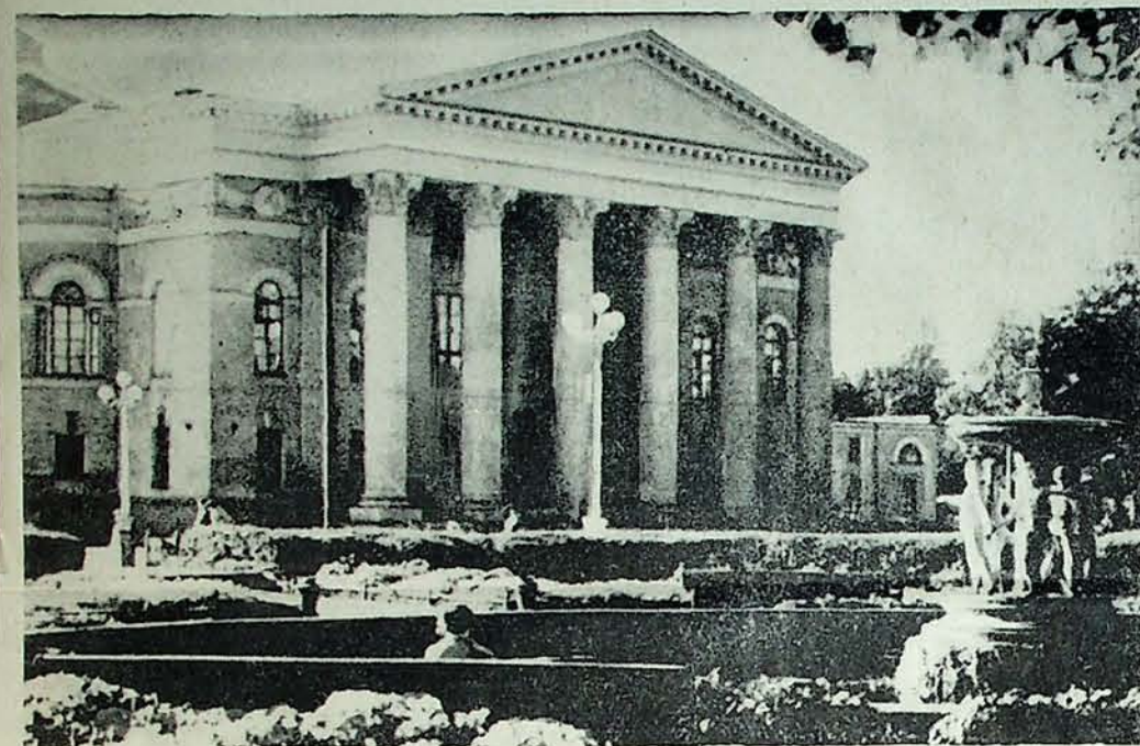
Im Stile der Stalin-Ära: Unter Verwendung stehengebliebener Mauern des Neuen Schauspielhauses wurde ein neues Theater mit vorgepiloten Säulen erbaut. Der Gesimse-Schmuck und die Säulen-Kapitelle sind Fertigteile, die in gleicher Weise auch bei anderen sowjetischen Bauten Verwendung finden. Die Figurengruppe vorne rechts am Bassin erinnert an den um die Jahrhundertwende üblichen Zuckerbäckerstil.
