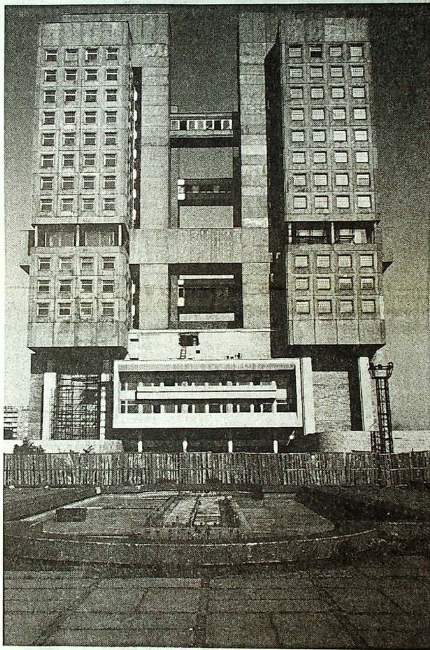
Weiterhin Beton im Kopf? Bauruine des „Haus der Räte“ - Symbol des sowjetischen Königsberg Foto Weber
