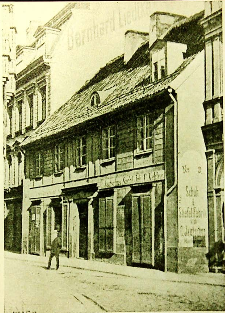
Kants ehemaliges 1893 abgebrochenes Wohnhaus, Prinzessinstraße 2
