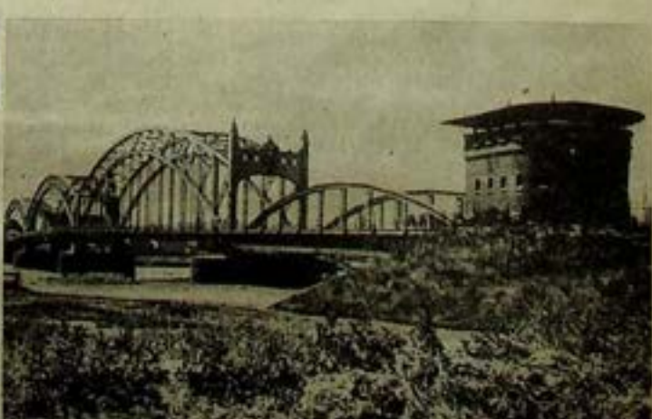
Die fertige Brücke von Übermemel aus.
