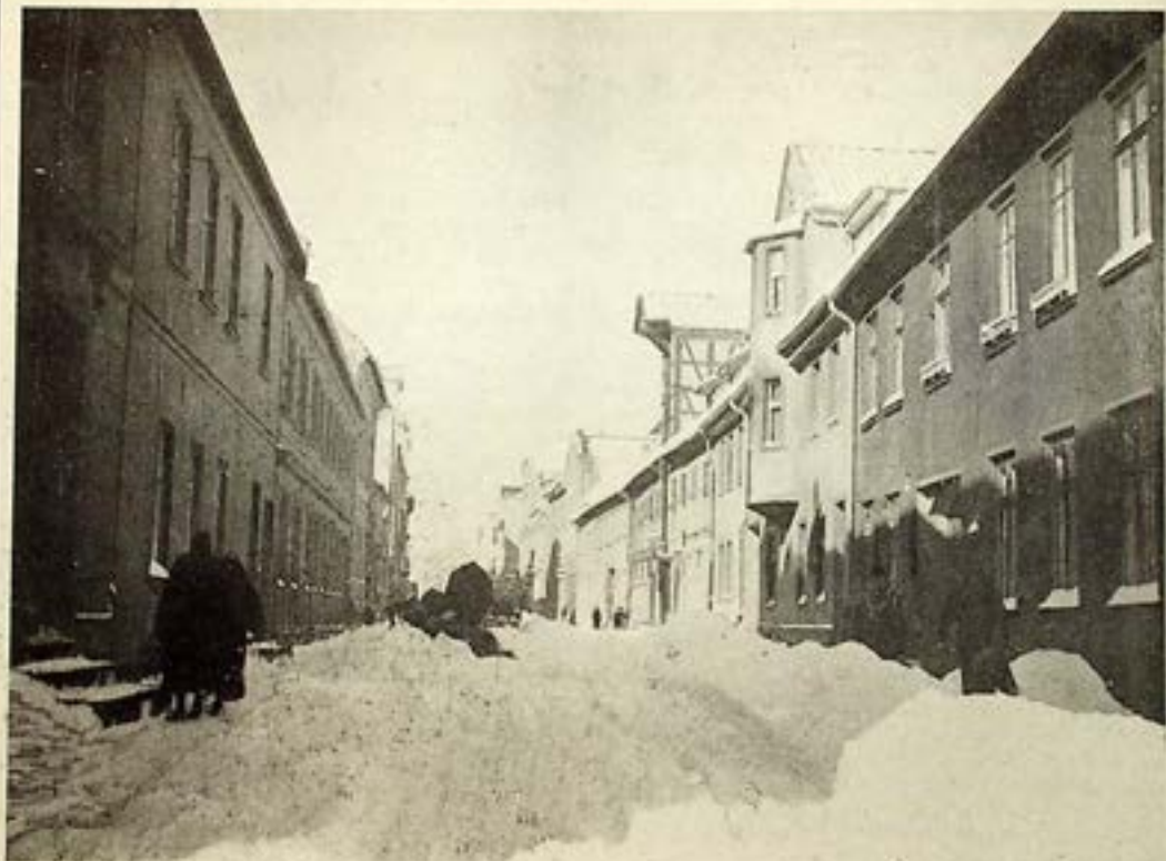
Blick vom Tilsiter Schenkendorfplatz in die Goldschmiedestraße. Über dieses Bild aus ihrer Heimatstadt plaudert die Verfasserin unseres heutigen Berichtes. Vergleichen Sie bitte auch unseren Artikel mit dem Titelbild unserer vorletzten Ausgabe, das die Schloßmühlenstraße mit der Stadtkirche im Hiplergrund zeigt.
