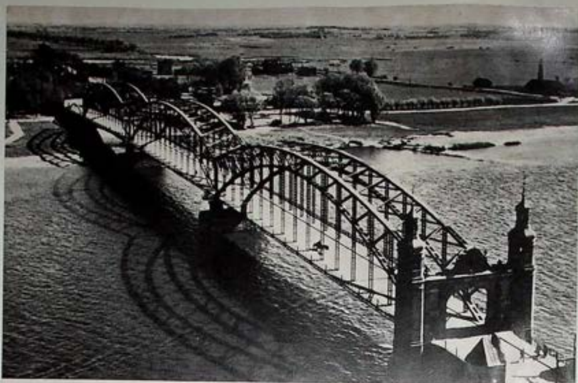
Der Memelstrom, Lebensader von Tilsit — Die Lauenburgbrücke, erbaut 1907
