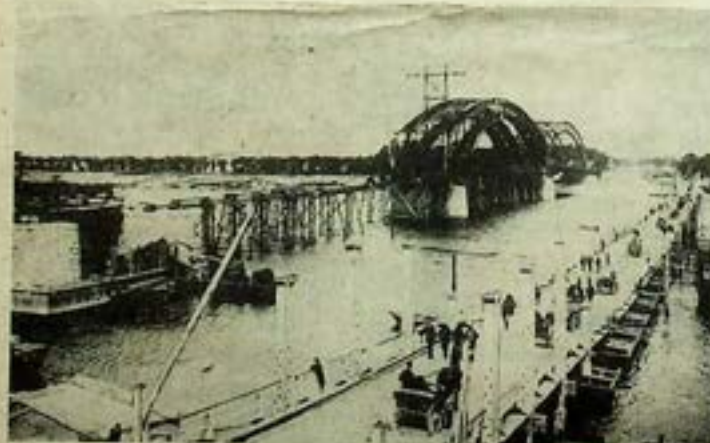
Eine Pontonbrücke verband während des Baues beide Ufer.
