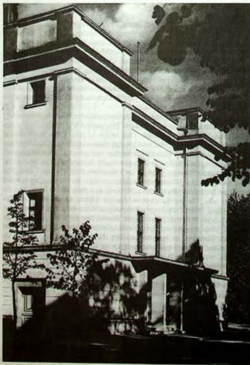
Die Fassade fiel der kommunistischen Gleichmacherei zum Opfer: Das Gebäude ohne Schnörkel und Zierat
