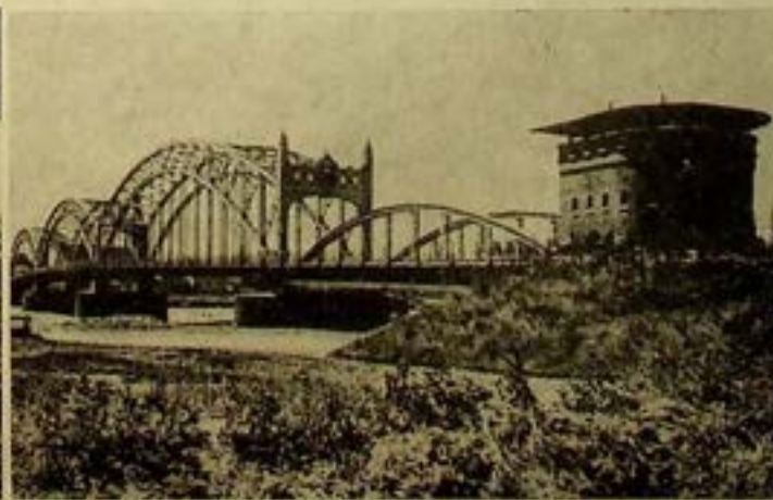
Die fertige Brücke von Obermemel aus.
