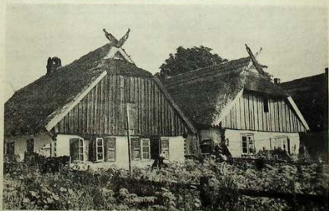
Oberes Bild: Häuser alter, landesüblicher Bauweise in der Elchniederung mit geschnitzten Giebelkrönungen.
