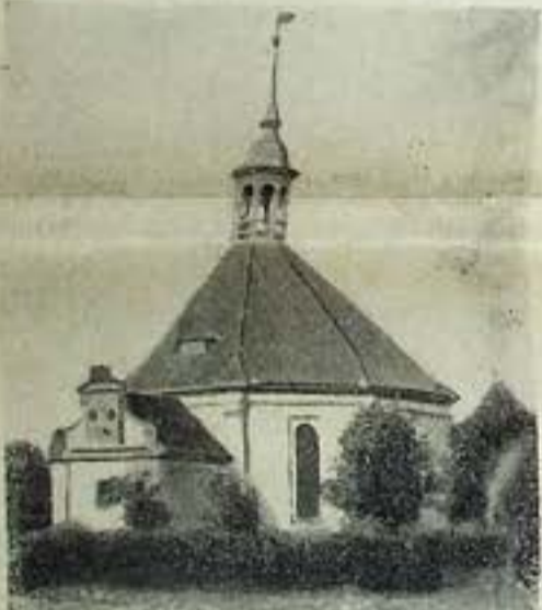
Die 1703 vollendete Kirche zu All-Lappien (Rauterskirche) ist nach einem Entwurfe Philipps von Chiese, des Architekten des Potsdamer Stadtschlusses, erbaut worden. Zum Vorbild für den achteckigen Bau diente die Marktkirche in der holländischen Stadt Leyden. Chiese förderte durch Deichanlagen die Entwässerung der Elchniederung. — Berühmt war die 1701 von Josua Mosengel gebaute Orgel.
