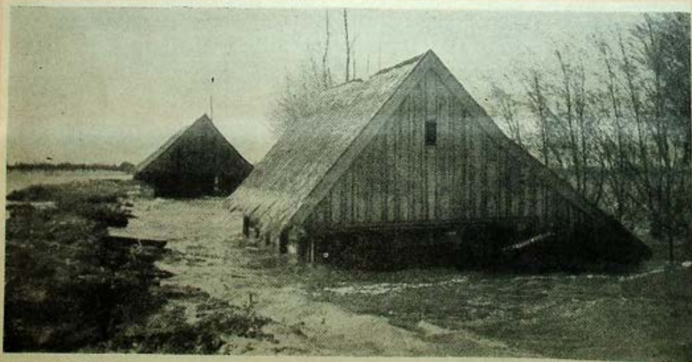
Der Deich ist gebrochen
