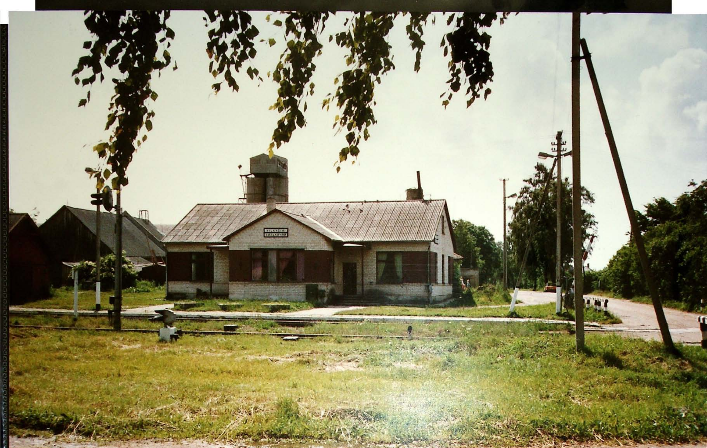
40. Wilkieten - Bahnhof 1990, verändert durch Neubau
