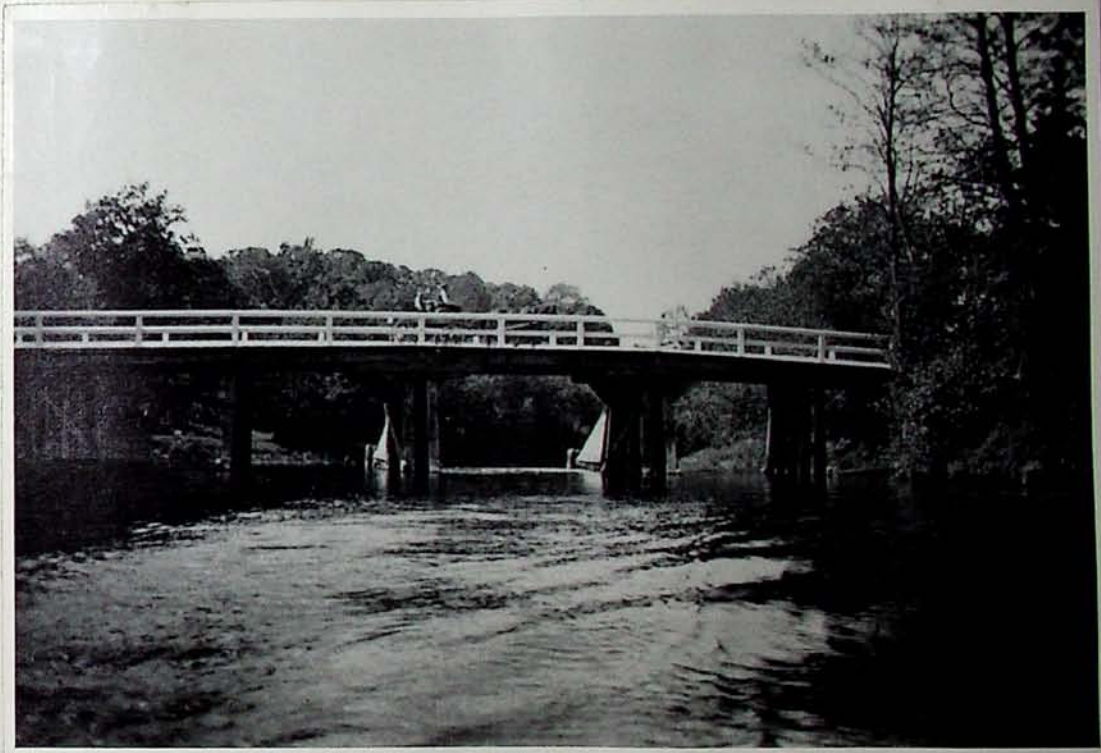
Dangebrücke in Tauerlauken
