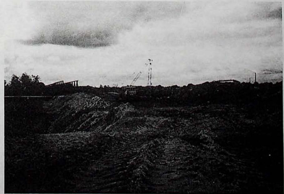
Die Baustelle am nördlichen Ende der Uszlenkis-Brücke – Juni 1993.
