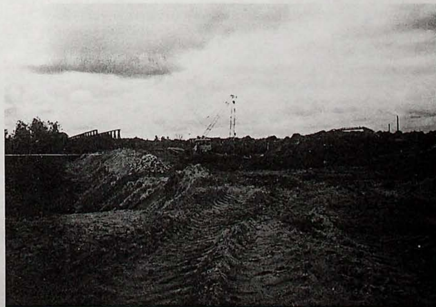
Die Baustelle am nördlichen Ende der Uszlenkis-Brücke – Juni 1993.
