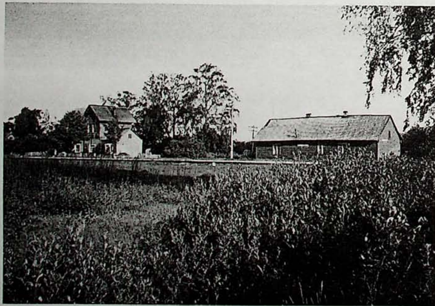
Der Guddeener Bahnhof, links das alte, rechts das neue Stationsgebäude.
