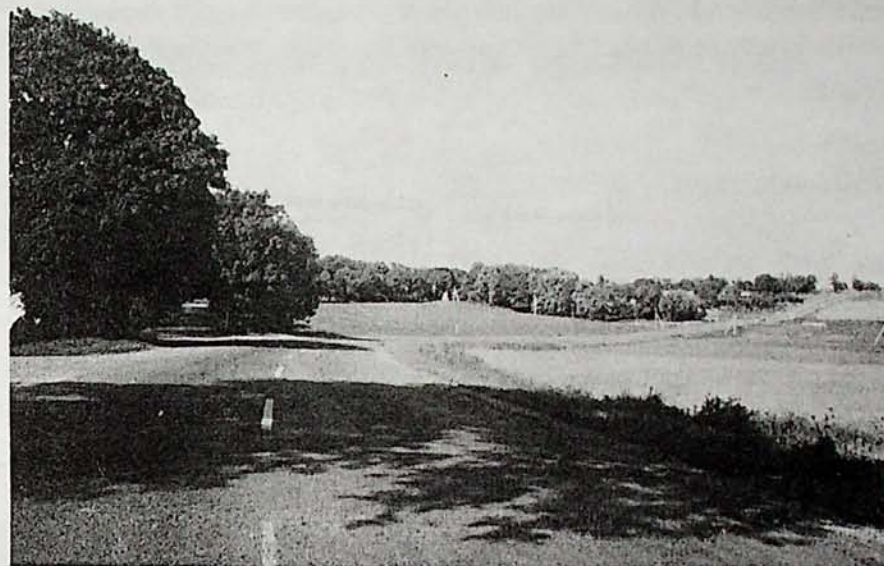
Straßenverlegung vor Piktupönen: geradeaus die alte Chaussee, nach rechts abbiegend die neue Straße.
