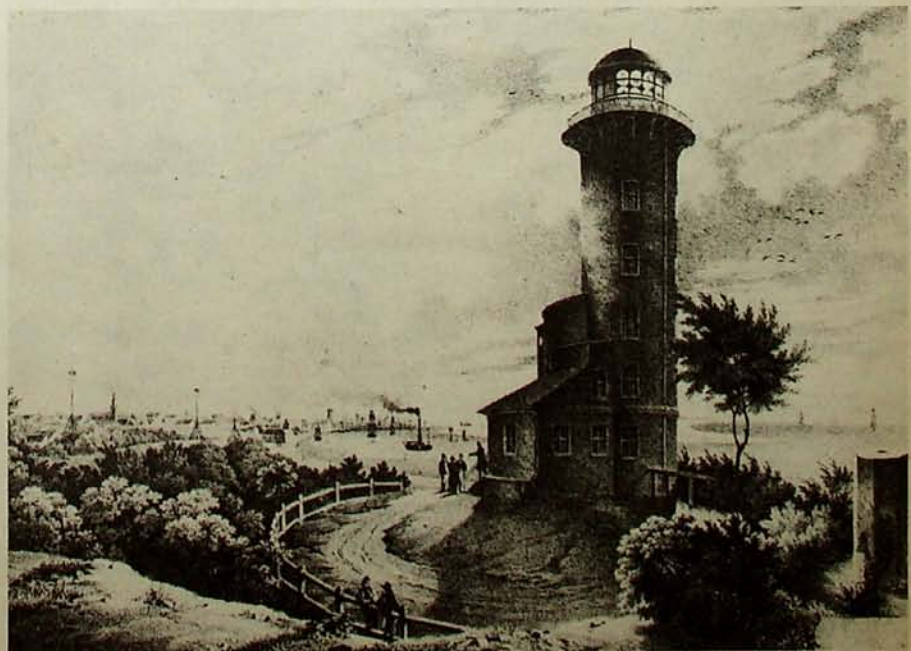
Imposant ragte der drittälteste deutsche Küstenleuchtturm in den Himmel
