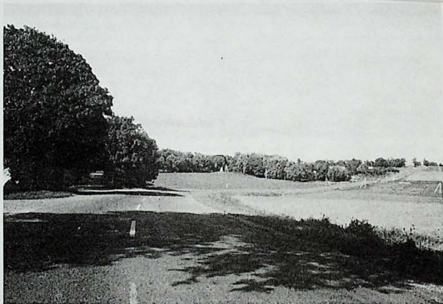
Straßenverlegung vor Piktupönen: geradeaus die alte Chaussee, nach rechts abbiegend die neue Straße.
