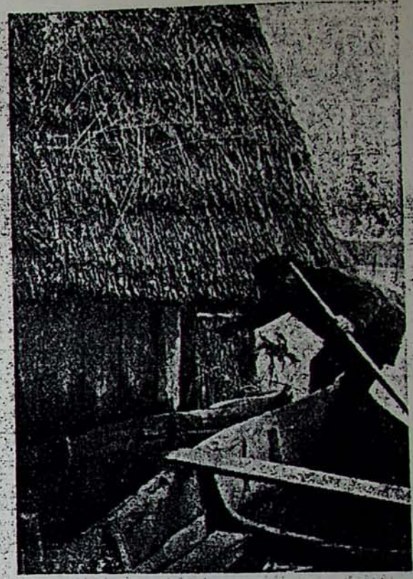
Bis unter das schilfgedeckte Dach ging das Wasser
