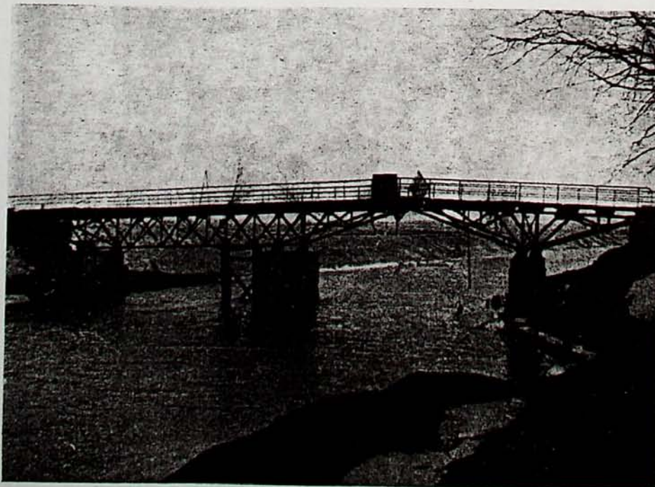
Die erste Kanalbrücke ist wieder intakt
